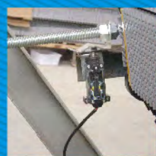
梯级链断裂保护装置 Step-chain breaking protector
